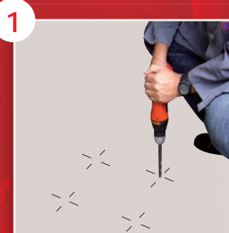
1 Perçage des trous de fixation
