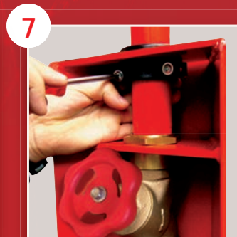
7 Mise en place du collier de maintien du dévidoir
