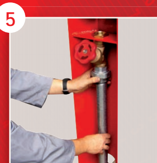
5 Raccordement de l'alimentation
