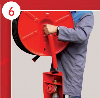
6 Mise en place de la bobine
