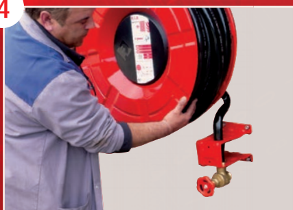
Mise en place du dévidoir par une seule personne
