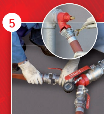
5 Raccorder les 2 flexibles souples DN45 des 2 entrées du collecteur aux 2 prises d'incendie à contrôler
