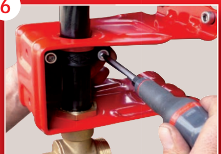
Assemblage du collier par deux vis
