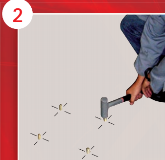
2 Mise en place des goujons
